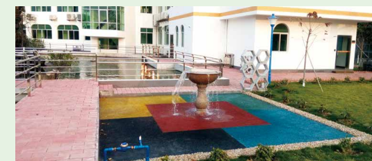
彩色透水混凝土喷泉
