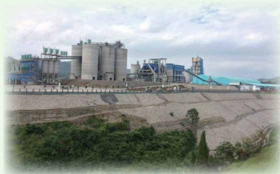
金沙公司进厂大道侧边坡
