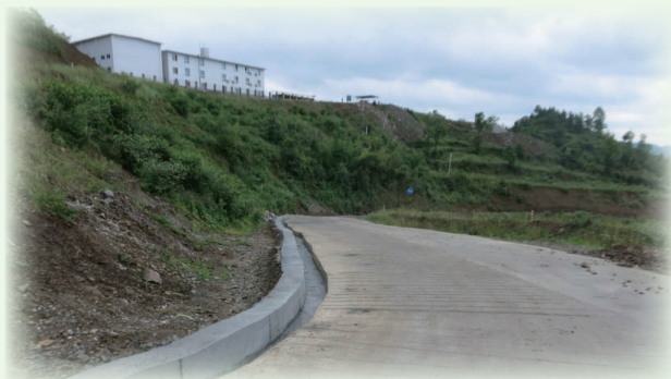
金沙公司上矿山道路边坡及水沟治理
